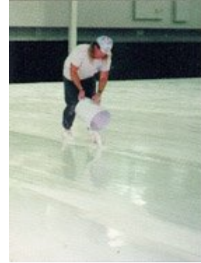
Resurfacing over epoxy... Pour
